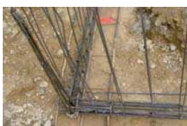
Nœud de chaînage - Continuité mécanique
